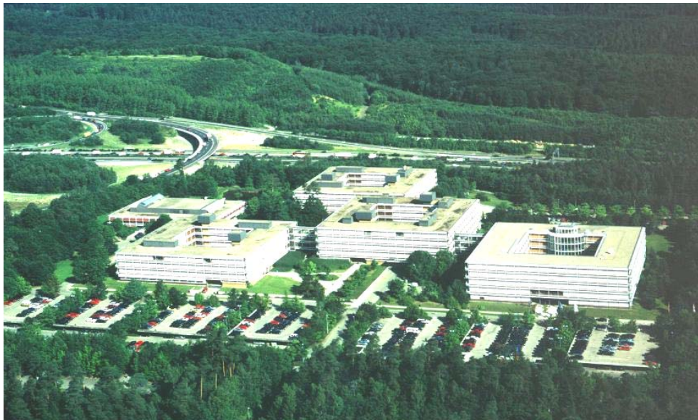
Abbildung 5: Hauptverwaltung der IBM Deutschland in Stuttgart-Vaihingen
